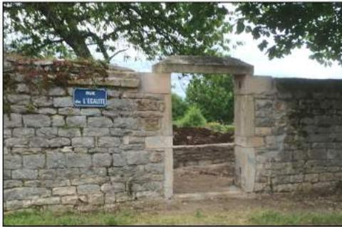
Nous avons fait reprendre les murs éboulés de l'école des garçons et de la cure, démonter les jambages de l'ancienne porte obturée de main de maître à l'aide de moellons bruts, l'avons fait remplacer par un mur en pierres jointoyées, et créé une porte avec accès handicapés à la cure. Ces travaux ont été réalisés par un de nos entrepreneurs locaux.
