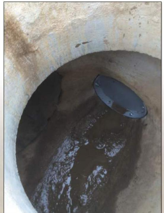
Pièce pour dévier à gauche l'écoulement.
